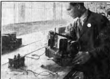
Fig. 4 — Controllo delle saldature.
