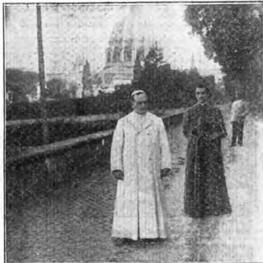
Sua Santità, accompagnato da Monsignor Confalonieri si reca a visitare i lavori della nuova stazione
