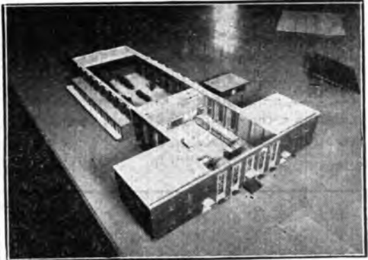
Modello della Soc. Lorenz per la nuova stazione ultrapotente di Heilsberg. (La potenza di 60 Kw. può essere portata a 120 Kw.) Nel presente modello sono visibili la stazione trasmettente, la sala delle macchine e le torri di raffreddamento
