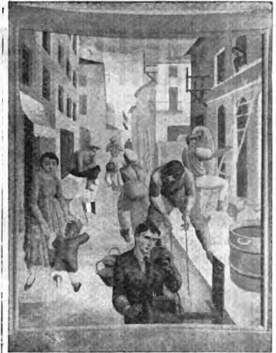
Ginlio Rosso - La posa dei cavi in città (fot. Bertoglio)
