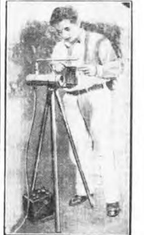
L'apparecchio destinato ad uccidere gli insetti delle piante con le onde ad alta frequenza.
