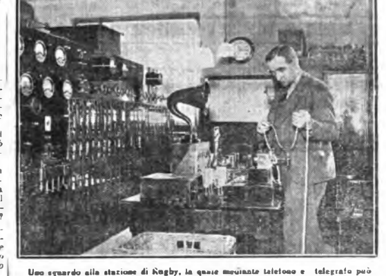
Uno sguardo alla stazione di Nogy, la quale mediante telefono e telegrafo può comunicare con tutto il globo. La fotografia ci rappresenta un addetto alla radiostazione mentre controlla un messaggio per Praga.
