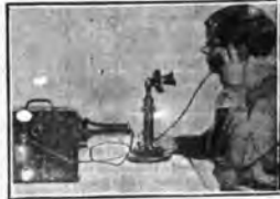
L'apparecchio che fa sentire i sordi, usato per parlare al telefono.
