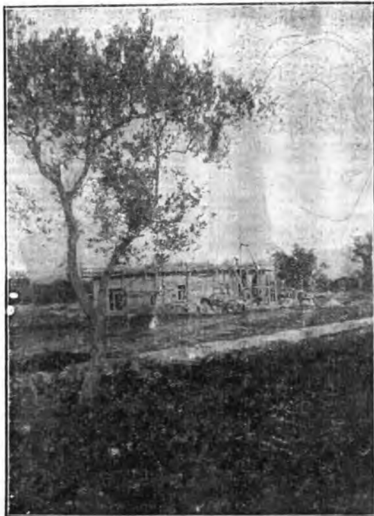
L'edificio della stazione trasmittente di Palermo attualmente in costruzione.
