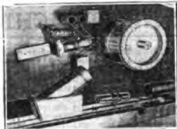
Il tamburo con 50 spesse, che divide le figure trasmesse, per radio in 2500 elementi, usata dalla Telefunken negli ultimi esperimenti di televisione con onde corte.
