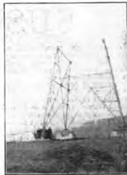
L'antenna in costruzione.
