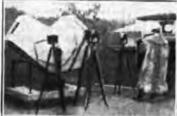
Lo spettroscopio dell'Osservatorio di Tromsø, in Norvegia, per analizzare la luce dell'aurora boreale.
