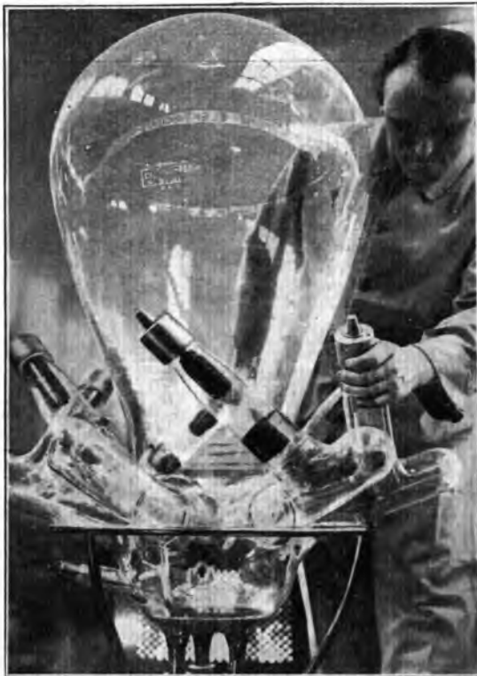
Dalla Fiera Primavera di Lipsia — Recipienti di vetro di un raddrizzatore a vapore di mercurio (400 Amp., 300 Volts, corrente continua)
