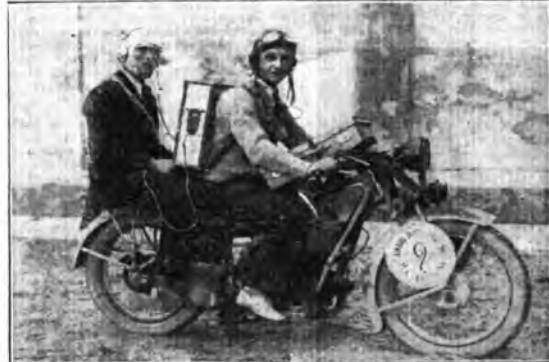
Agostino Paganini ed Enzo Sperari, i valorosi motociclisti di Cremona, che hanno bravamente partecipato Radio-auto-raduno, ottenendo la ricompensa delle comunicazioni radiofoniche per mezzo di un apparecchio «otto valvole» a doppia antenna fabbricata da loro stessi e che uno di essi, a turno, recava in spalla come uno zaino.
