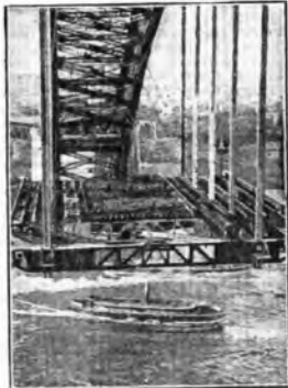
Il ponte in costruzione nel porto di Sydney (Australia) che avrà l'arcata più grande del mondo.
