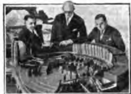
Il modello del palazzo della scienza che sorgeerà nella prossima Esposizione mondiale di Chicago.
