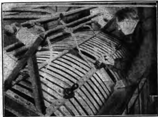
Particolare di una delle due potenti stazioni di Mosca.
