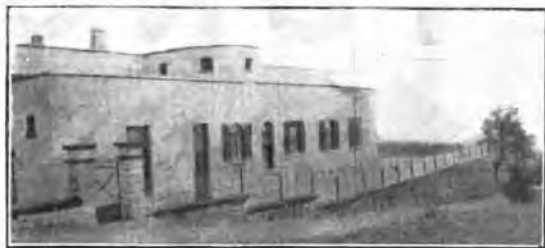
Parte anteriore dell'edificio del trasmettitore.
