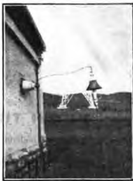
Cabina di staziona e diacca di aereo.
