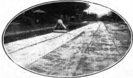
La nuova strada costruita nel Texas con uno strato di pece ricoperto con la tela.
