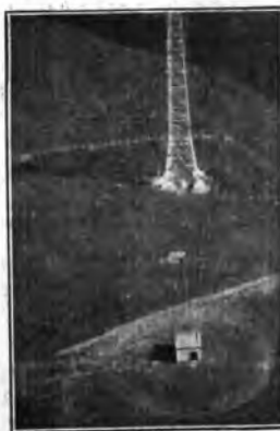
La cabina di stazione.
