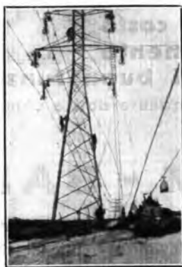
La prova della resistenza dei fili elettrici e dei pali di sostegno con l'uso di sacchi pieni di sabbia.
