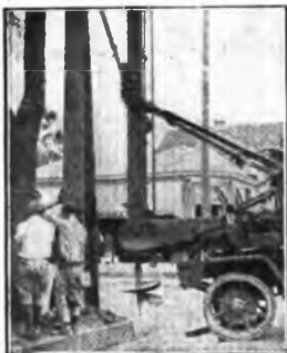
La nuova macchina che pianta soltanto pali al giorno, rimpiazzando anche i vecchi.
