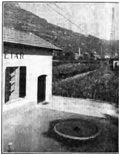
L'edificio del trasmettitore.
