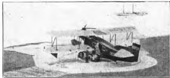
La piattaforma girevole del piccolo aeroporto dell'isola Catalina destinata a mettere in posizione di partenza gli aeroplani.
