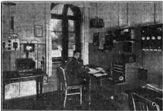
Una delle stazioni della Radiopolizia berlinese. A sinistra si nota l'apparecchio ricevente collegato con la stazione centrale della città, che emette su onda propria (1134 m.) i segnali d'allarme alle diverse sezioni periferiche,
