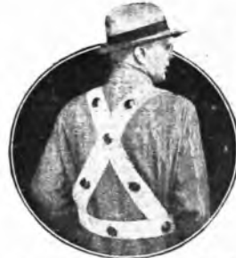
Come sono disposti i riflettori di vetro destinati a proteggere gli operai delle strade durante la notte.
