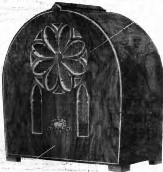
"Il RECORD 1932,, è un piccolo apparecchio a sopra-mobilità, di elegante artistico aspetto a 4 Valvole, di cui 2 schermate, 1 pentodo e 1 raddrizzatrice, diffusore elettrodinamico, chassis metallico di un sol pezzo. Comando unico. Riceve tutte le stazioni Europee. L'apparecchio di rara potenza, selettività, purezza e perfetta tonalità sarà certamente il Vostro inseparabile amico.
