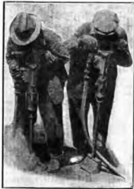
Due perforatrici in funzione delle quali quella di destra è fornita dell'apparecchio che assorbe il polvere.
