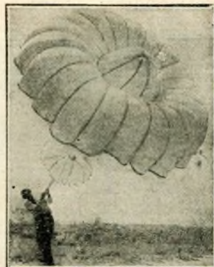
Il nuovo paracadute che ne porta uno più piccolo per assorbire le scosse e facilitare l'apertura.
