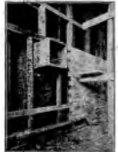
Fig. 1. Dettaglio costruttivo della parte interna del locale del Palazzo del Rolo, che nel 2° supporto acustico della parete in marmo.
