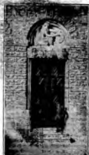
Finestra secondaria (via Muroletta).
