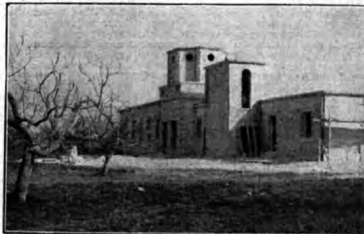
La stazione di Bari in corso di costruzione.
