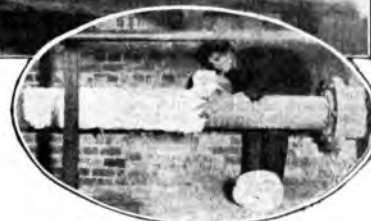
Il vetro lavorato come la seta. Nell'ovale: Un tubo metallico ricoperto con una tela di vetro.
