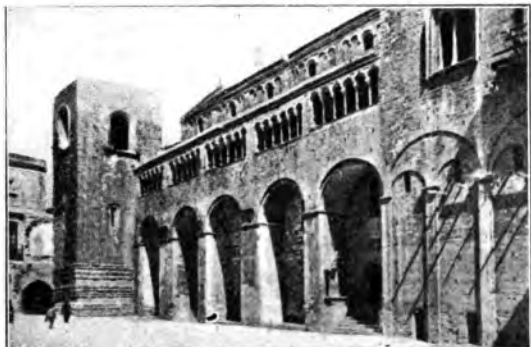
Reale Basilica di San Nicola, dopo i restauri. (Fot. Picarelli).
