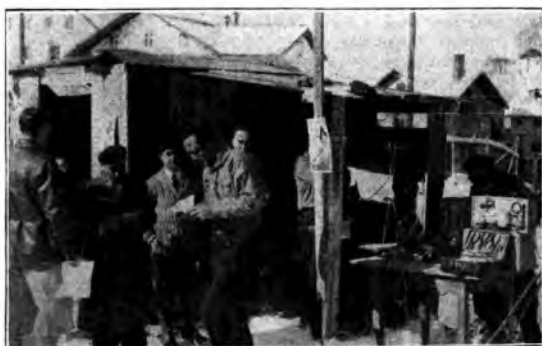
Il lavoro ferve al villino della radio.
