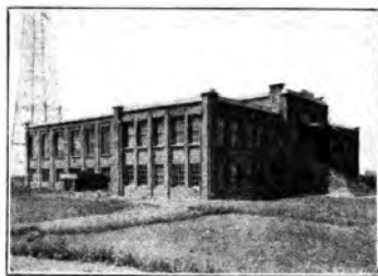
L'edificio dei trasmettitori di Velthem.
