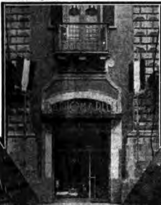
Facciata del negozio con zibona soprastante destinato a ufficio
