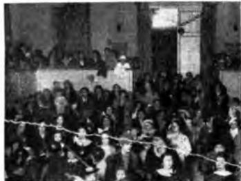
Una piccola parte degli interrennati.
