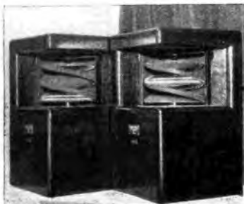
Ricevitori di tipo meccanico, a proiezione su spirale di specchi (Guenza d'analisi 90 e 120 linee).
