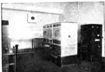
Il trasmettitore ad onda ultra corta (lunghezza d'onda m. 6,30) dell'E.I.A.R. a Torino.
