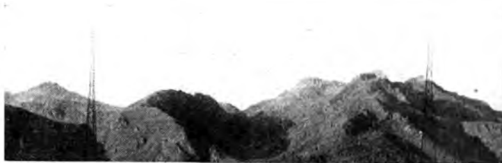
Le due torri di 125 metri che sostengono le antenne del trasmettitore del Ceneri.
