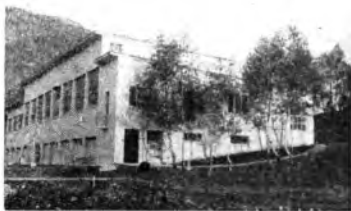
L'impianto nazionale del Monte Ceneri. La casa delle macchine.
