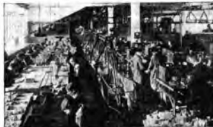
Zona del reparto montaggio e chassis a radio riservata agli apparecchi di controllo finale. Osservare al centro il trasportatore, a sinistra parte del banco di montaggio servito dal tappeto scorrevole.
