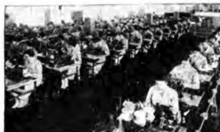
Veduta variata del reparto avvolgimenti (messa in evidenza delle nuove macchine avvolgitrici).
