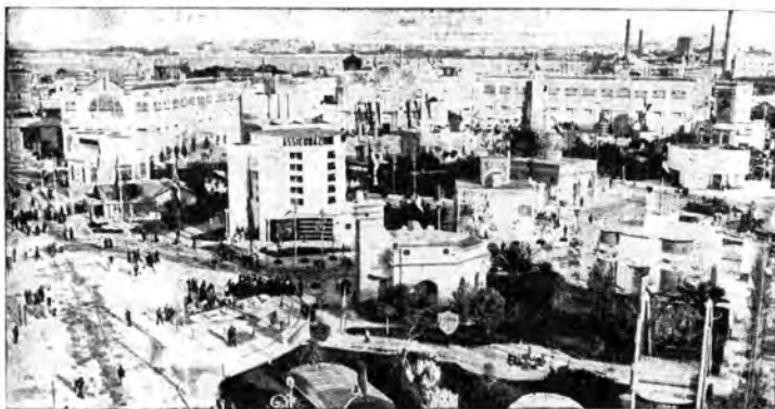
Visione panoramica: in fondo il Piazzale Napoli con l'edificio della Moda.
