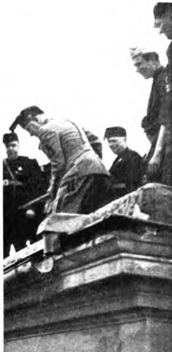
Il Duce dà il primo colpo di piccone per l'allargamento di via Dei Sediari.
