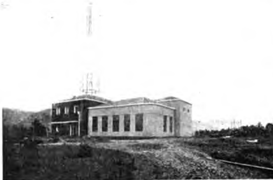
L'edificio principale del trasmettitore.
