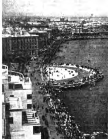
Bari: Lungomare dalla Torre della Provincia.
