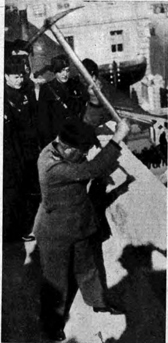
Il Duce inizia i lavori per la sistemazione degli impianti delle Ferrovie in Roma.
