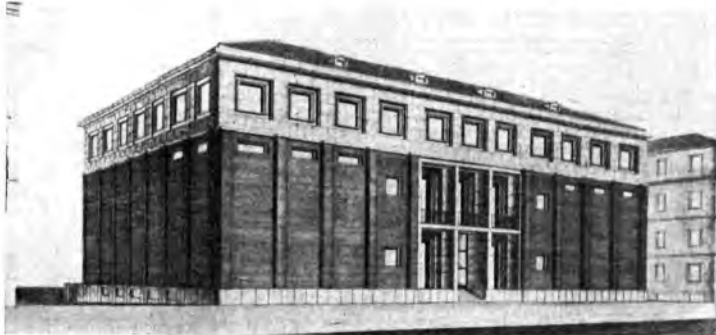
Torino - Il nuovo edificio per auditori (9000 mc. di auditori).
