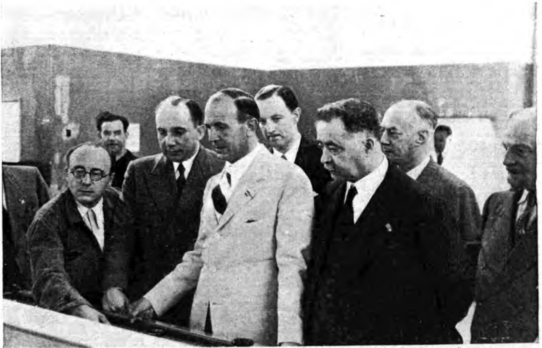
S. E. Alfieri e l'Accademico prof. Pession assistono alla messa in moto automatica dell'impianto di Santa Palomba, effettuata al banco di manovra.
