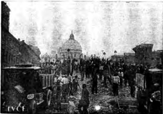
Gli operai addetti alla demolizione dei «Borghesi» salutano il Fondatore dell'Impero.
