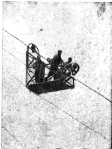
Carrello scorrevole sugli stralli per la manutenzione dell'antenna.
