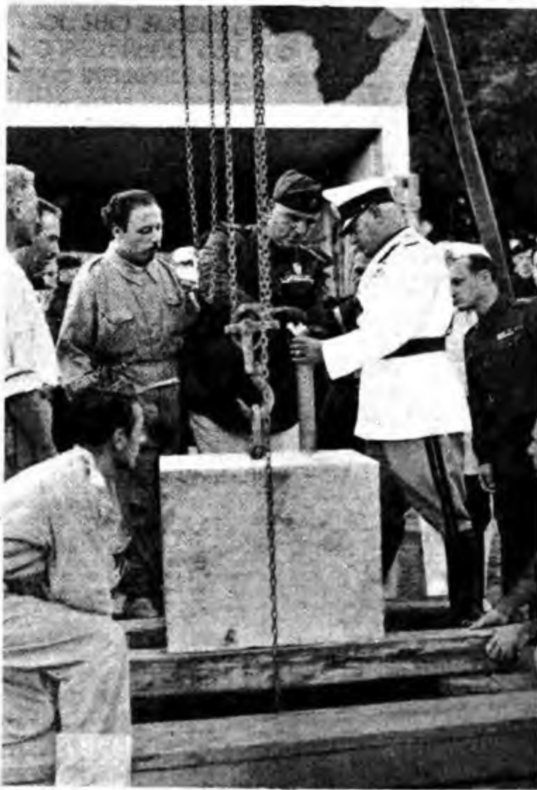
Il Duce posa la prima pietra per la nuova sede del Ministero dell'Africa Italiana.
