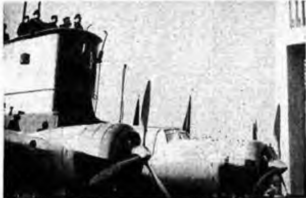
Il Fondatore dell'Impero parla agli operai dei cantieri di Montalcone.
