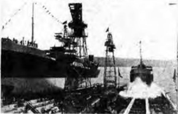
Al cantiere di San Marco, tra vari di navi ed acceleratori di manovre.
