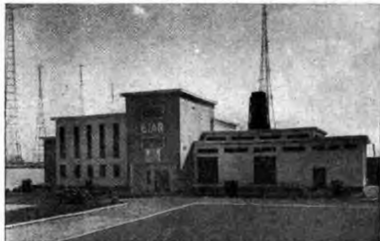
Edificio n. 2. In esso sono installati tre trasmettitori da 1 kW ed uno di 50 kW.
