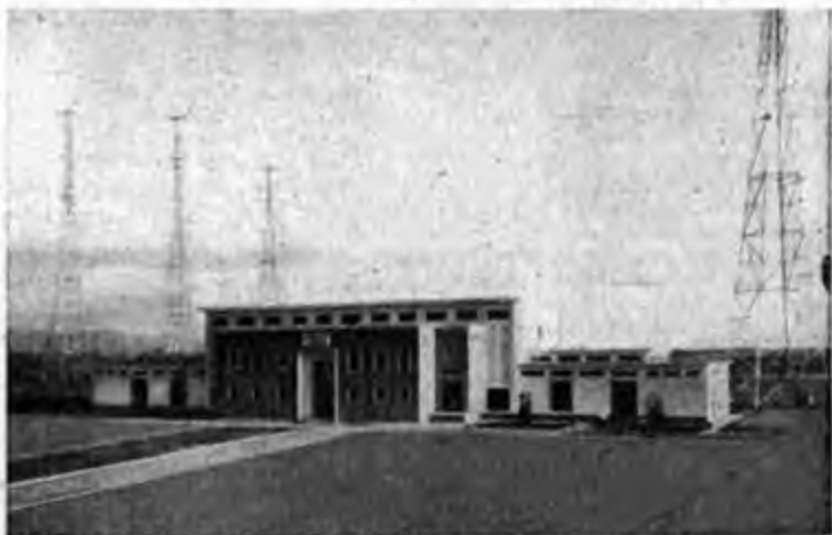
Edificio n. 3. In esso sono installati quattro trasmettitori: due da 50 kW e due da 100 kW.
