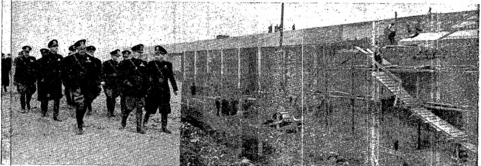
La Roma Mussoliniana: Il Duce visita i lavori della « Metropolitana », la grandiosa rete sotterranea che, congiungendo la stazione Termini con la « E. 42 » avrà una lunghezza complessiva di esercizio di circa dieci chilometri e una lunghezza di impianto di oltre undici chilometri. Sul doppio binario i treni a trazione elettrica potranno raggiungere la velocità di cento chilometri all'ora.
