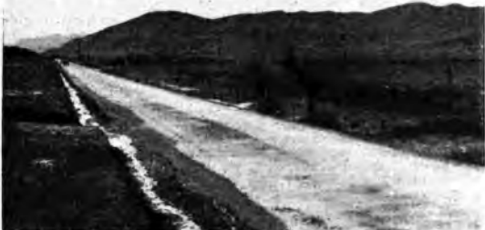
Lavori per l'autostrada Tirana-Durazzo
