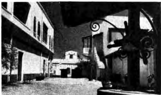
Interni di nuove costruzioni a Dire Dava
