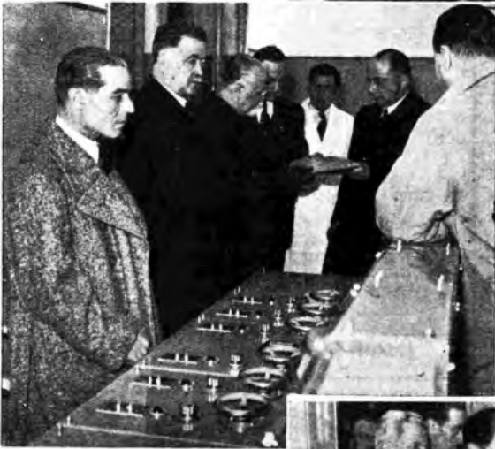
La visita agli impianti.
