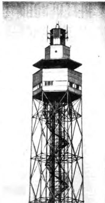
Le antenne trasmettitori di radiovisione in sommità della torre Littoria di Milano. — L'antenna « video » è unica al centro; le antenne del suono sono tre, ugualmente distanziate e provviste di specchio riflettore.
