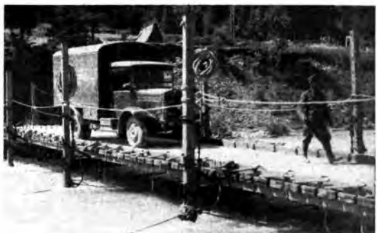
Ponte costruito dal nostro genio pontiere a Lanleibourg.
