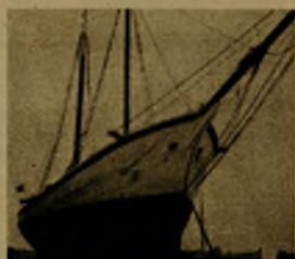
Lavoro italiano: valore contrasta in un cantiere italiano a Tunisi
